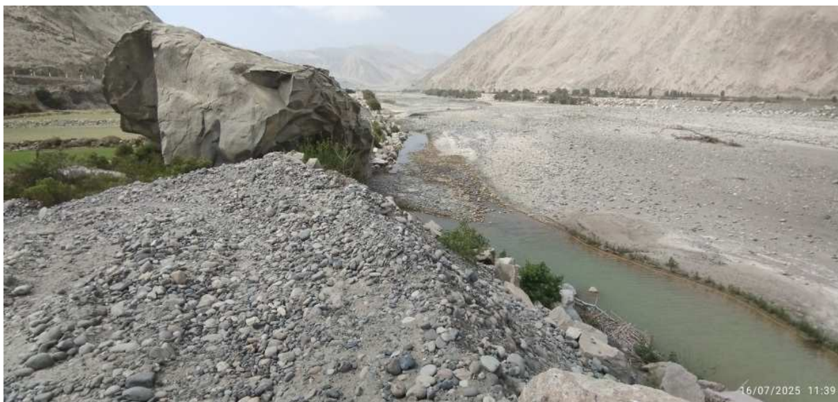
FIGURA N°03: TRAMO 07 PUNTO FINAL DE PUNTOS CRITICOS EN SECTOR PUERTO VIEJO - AYANQUERA Y PUTO FINAL DE TRAMO N° 07, SE OBSERVA QUE ENROCADO FUE ARRASTRADO Y DIQUE SE ENCUENTRA SIN PROTECCION., SECTOR DENOMINADO COMO PIEDRA GRNADE
