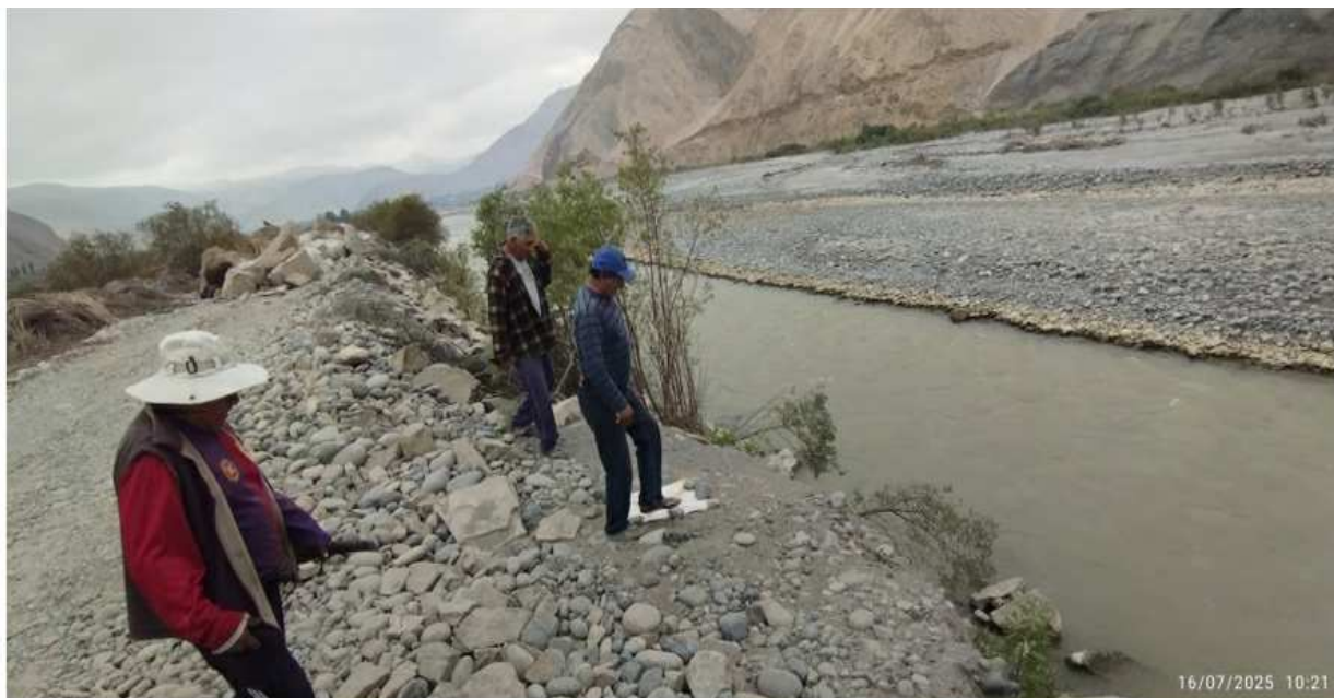
FIGURA N°02: TRAMO CRITICO 05, INICIO DE TRAMO CRITICO DE 845 ML. DE LARGO, SE OBSERVA PERDIDA DE ENROCADO O ROCAS EN CANTIDADES MINIMAS EN TALUD .
