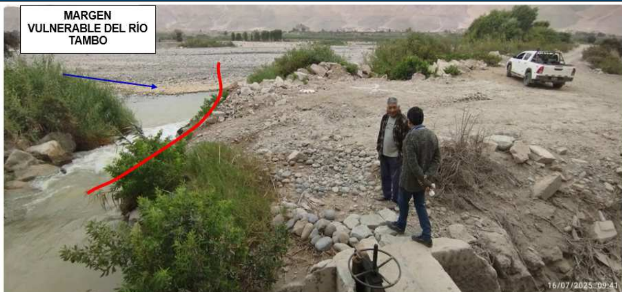
FIGURA N°01: TRAMO 01 INICIO DE PUNTO CRITICOS EN SECTOR PUERTO VIEJO - AYANQUERA, PUNTO CRITICO INICIO TRAMO 01 EN CAPTACION DE CD PUERTO VIEJO, SE OBSERVA ROCA CORRIDA A CAUCE PERDIDA DE ENROCCADO
